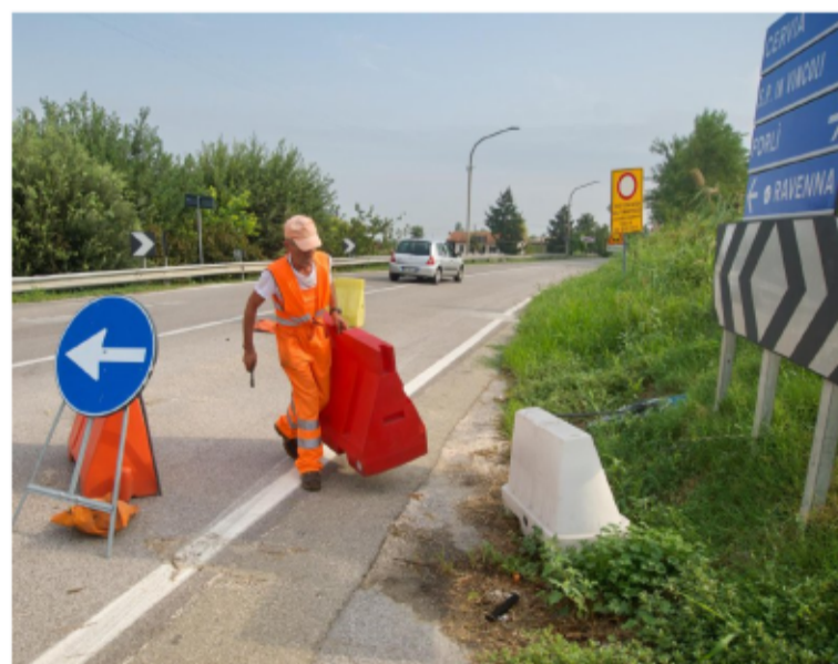
Lavori lungo la Ravegnana FOTOSERVIZIO MASSIMO FIORENTINI
